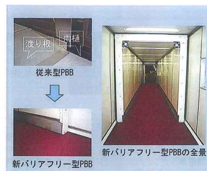
図2 トンネルと床板接続部 渡り板や両側の雨樋が無くなり、すっきりしたバリアフリー空間を実現
