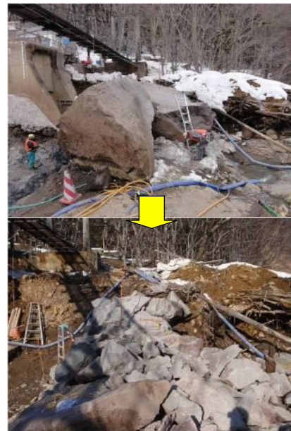
図2 落石破碎例
