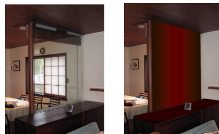
「ガラス制振壁」の場合（実際） 「間仕切壁」の場合（仮定） 意匠性検討例(空間開放性の向上)
