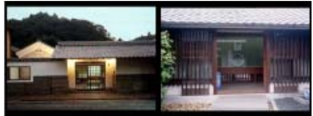
写真2 有田町における修景まちづくりの事例
