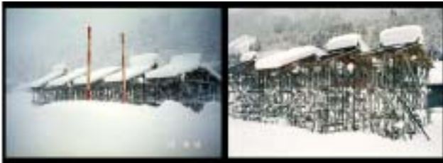
写真3 雪下ろしの必要のない屋根の実証実験
